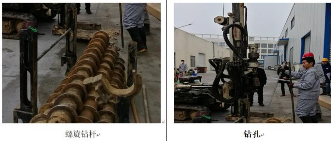
图 4-7 建井螺旋钻杆和建井钻孔
