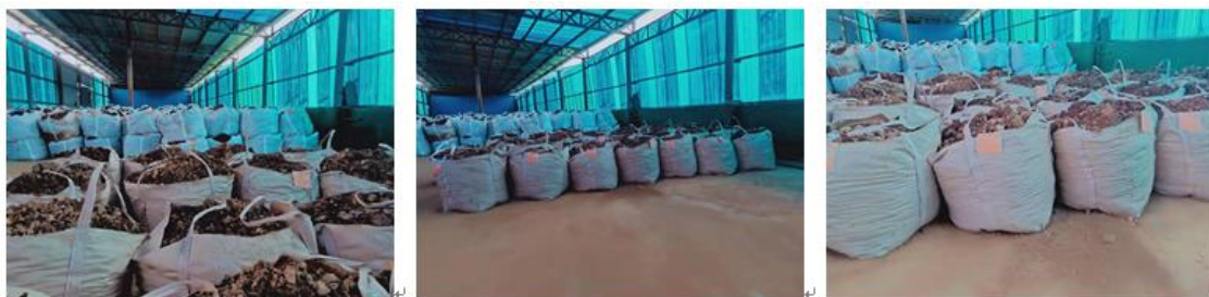
图 2-12 企业危废暂存库
